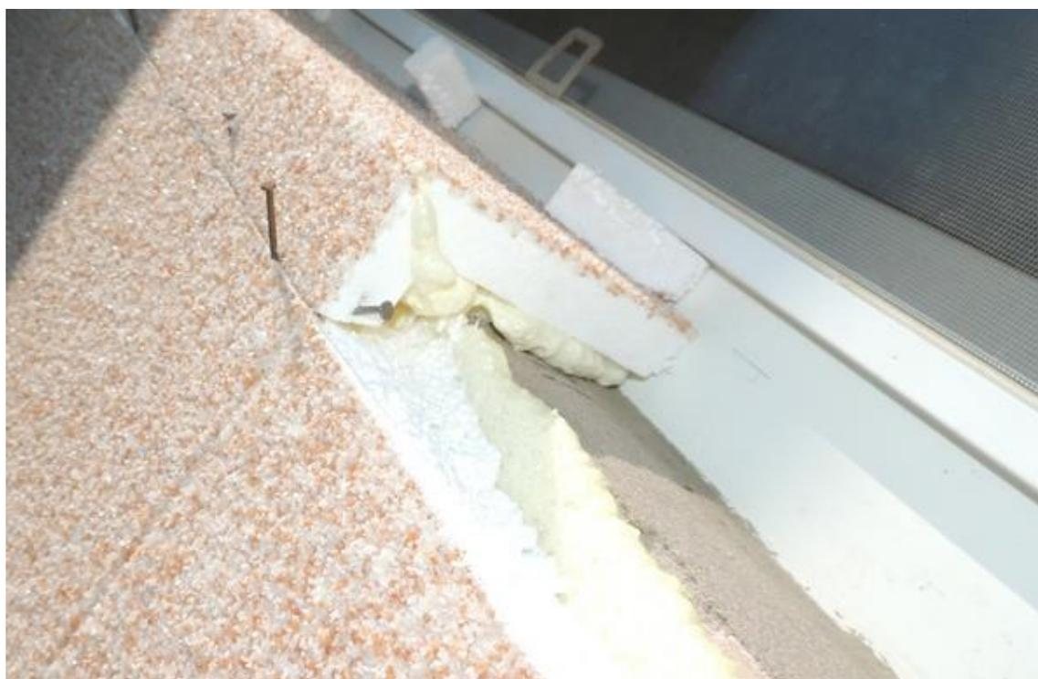
Рис. 4.6 Утепление откоса угловым элементом
